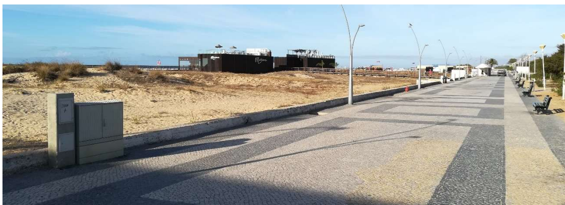
Figura 31 - Muro existente na marginal - zona poente do Casino de Monte Gordo.
