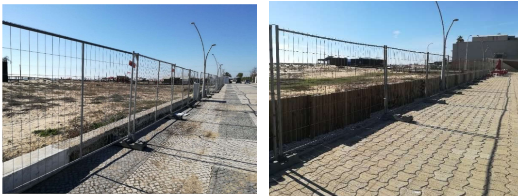
Figura 32 -Rede vedação zincada com base de cimento que ficará instalada durante o evento.
