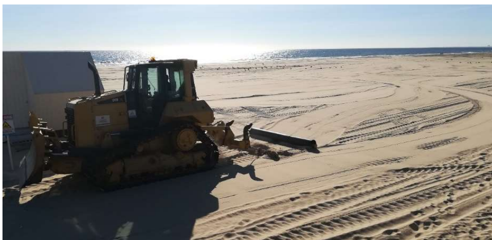
Figura 35 - Nivelamento do areal, após o término do evento.
